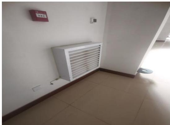
图 6-4 220kV 配电装置室通风
